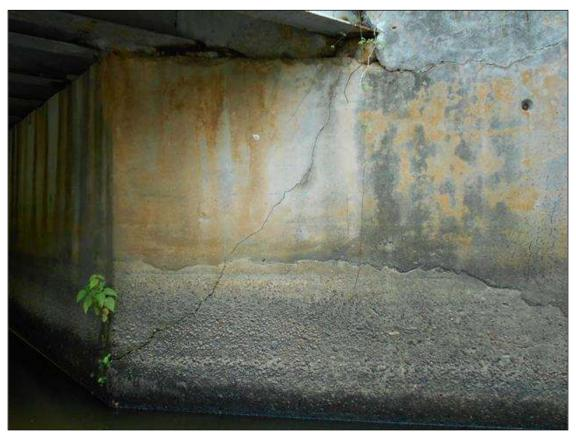
ABUTMENT 2 HAS DIAGONAL CRACKING UP TO 1/16" OPEN AT WINGWALL JOINT UP TO BEAM 11.
