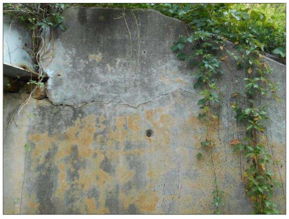
NORTHEAST WINGWALL HORIZONTAL HAIRLINE CRACKING ALONG CONSTRUCTION POUR JOINT.
